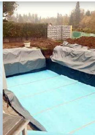
Vorbereitungen für die Installation
