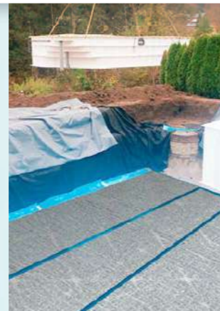
Verlegung der leitfähigen IQM Scan® Folie
