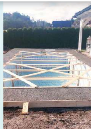
Abschluss der Installation
